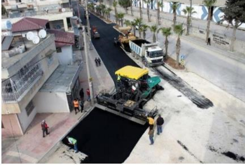
Karacailyas'ta hem altyapı hem üstyapı çalışması
